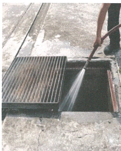
รูปภาพที่ 2.61 การขุดลอกท่อและรางระบายน้ำ
