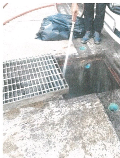
รูปภาพที่ 2.61 การขุดลอกท่อและรางระบายน้ำ
