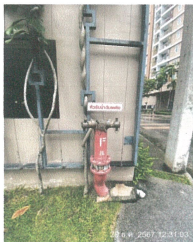
รูปภาพที่ 2.45 หัวรับน้ำและหัวจ่ายน้ำดับเพลิง
