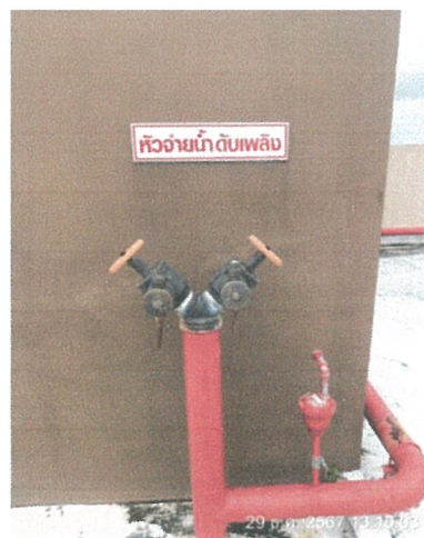
รูปภาพที่ 2.45 หัวรับน้ำและหัวจ่ายน้ำดับเพลิง
